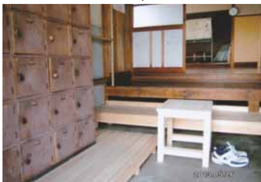
写真3 スノコ板と式台を設置した状態
