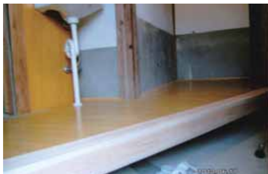
写真10 渡り廊下を設置し、手洗い器を調整した状態
