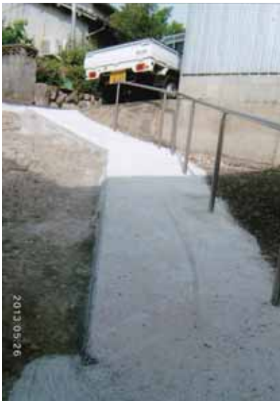
写真1 坂道をコンクリートで再舗装した状態
