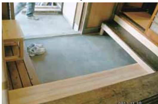
写真6 固定した踏み台を設置し、土間をコンクリートに舗装した状態
