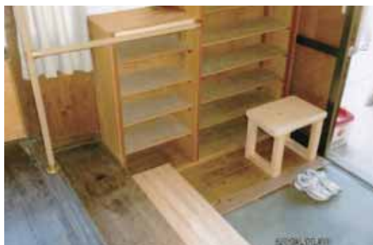
写真7 上り下り用に手すりを取り付けた状態
