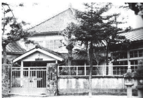
写真7-1 総社幼稚園 外観写真
