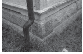
布基礎 出隅部分 写真 5 - 2
