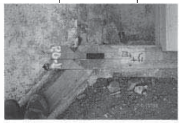
布基礎 出隅部分 写真 5 - 1
