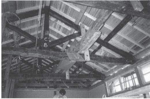
写真3-1 職員室部分 小屋組 旧旭東幼稚園
