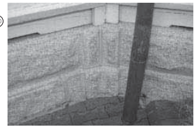
布基礎 入隅部分 写真 5 - 3
