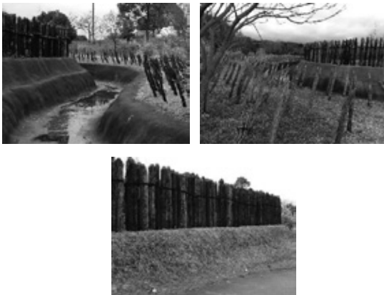
図1 外環濠の堀と城柵、逆茂木（H28.3.9撮影）
