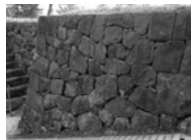
図19 打込接ぎ(松江城) (H27.11.6撮影)
