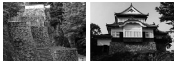
図15 岡山県高梁市・備中松山城 (H29.10.29撮影)
