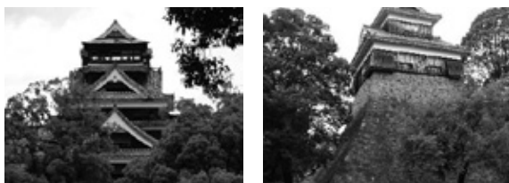
図22 熊本県熊本市・熊本城 (H28.7.11撮影)
